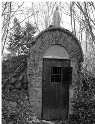
PIWNICA W OGRODZIE (zdj. stan aktualny)
